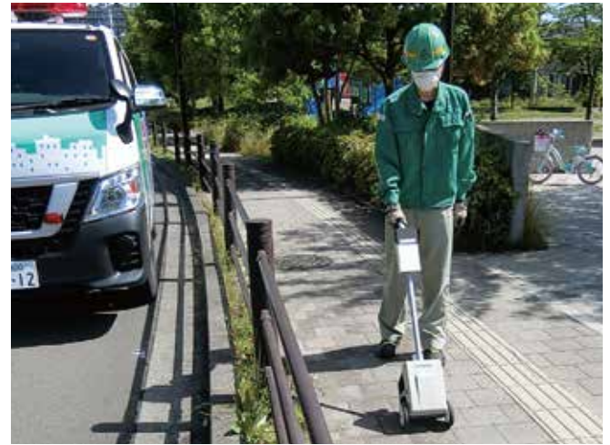
導管漏えい検査▲
