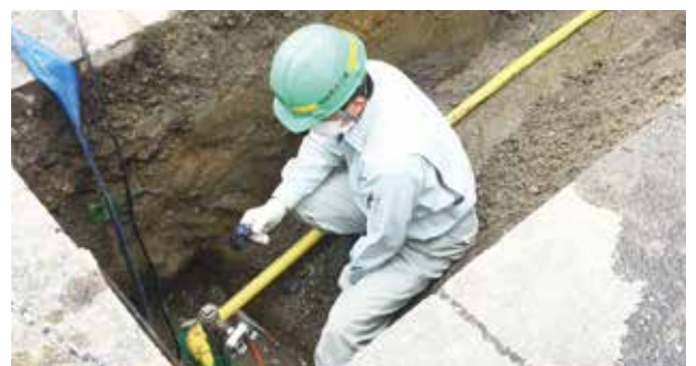
ガス管取替工事の検査▲
