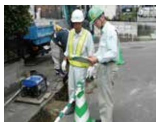
現場パトロールの様子▲
