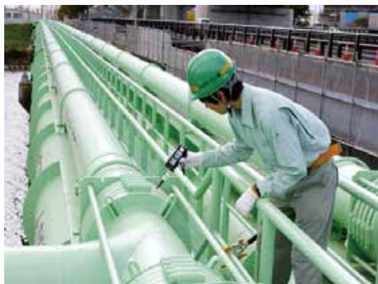
導管漏えい検査▲
