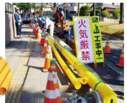
敷設作業の様子▲
