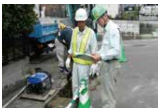
現場パトロールの様子▲
