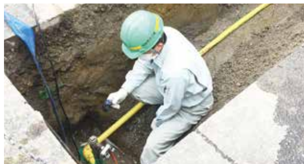
ガス管取替工事の検査▲
