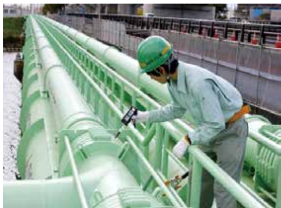
導管漏えい検査▲
