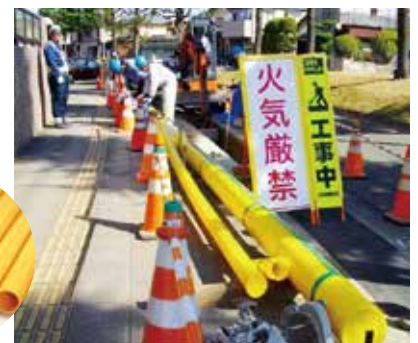
敷設作業の様子▲
