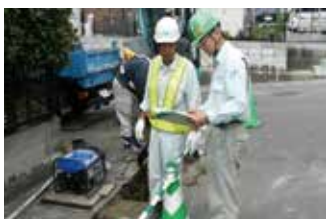
現場パトロールの様子▲
