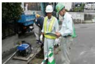
現場パトロールの様子▲
