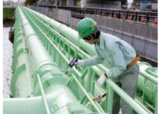
導管漏えい検査▲
